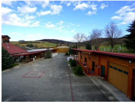
Innenhof Richtung Westen
